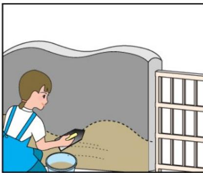
4. 割りタイル（クラシュタイル）を張る部分に、かるかるブリック専用モルタルをコテで5mm程度塗る。モルタルはあまり広い場所は塗らない下さい、モルタルの表面が乾燥して接着しにくくなります。モルタルは0.25平米以下づつ塗りタイルを張って下さい。
