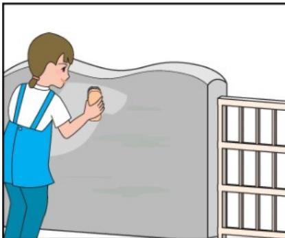
1. ブロック又はコンクリートの強度がない場合補強する。ブロックまたはコンクリート面のホコリや汚れを除去する
